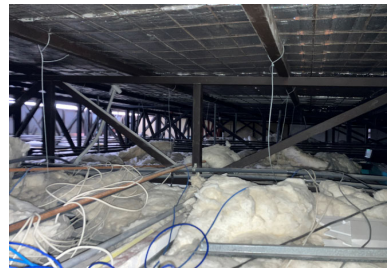
Detalle estructura techo
