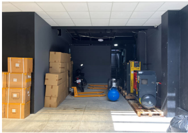
Área de compresores
